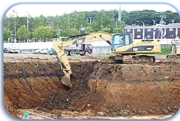
②基礎掘削工事を行っている様子
