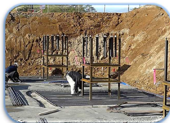
④基礎工事の様子
