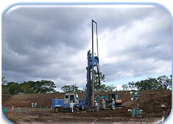
③地盤改良工事を行っている様子
