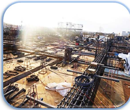
1階躯体の作業の様子。
