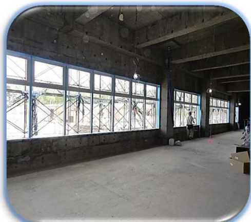
1階に窓枠を取り付けています
