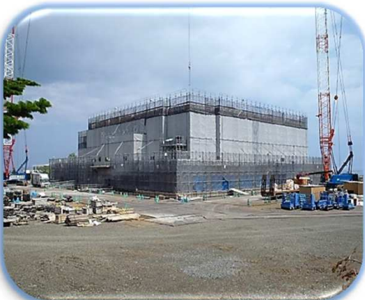
現在の建築中の新病院
