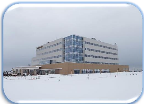
足場が撤去され、すっきりとした外観
