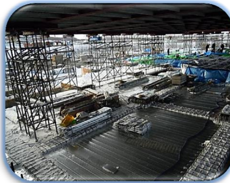
防寒養生用の上屋を組立中です
