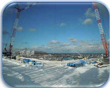
基礎工事が進められております
